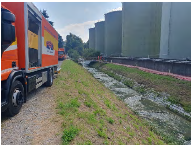
Figura 8 – Intervento R-39 in zona Cercera.
