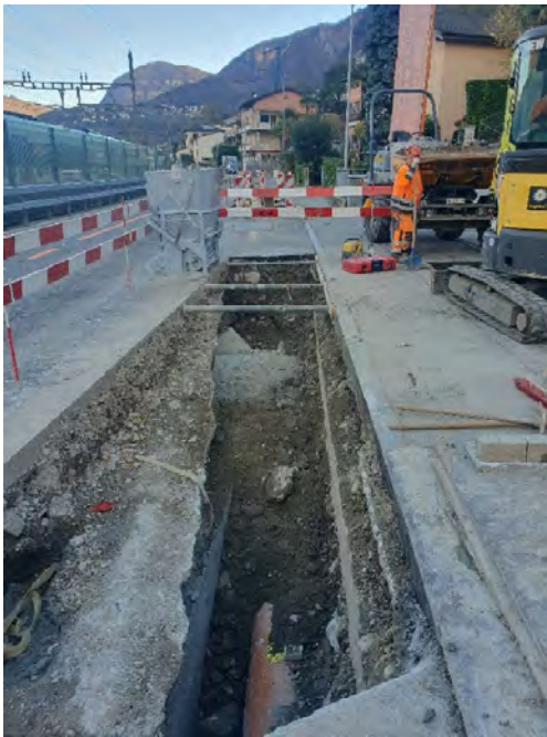
Figura 7 – Intervento S-03 a Capolago.
