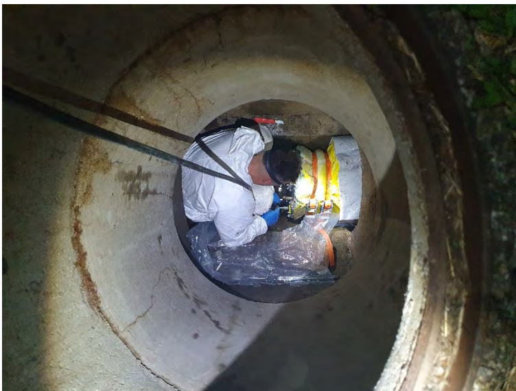
Figura 5 – Intervento R-52 a Stabio.
