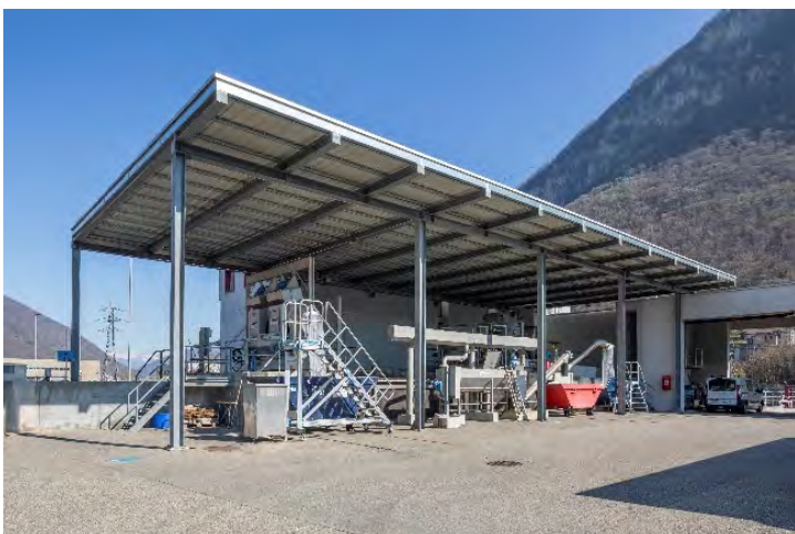
Nuova copertura con pannelli FV.
