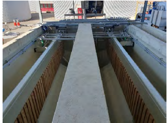
Ponte dissabbiatore e estrazione grassi/oli
