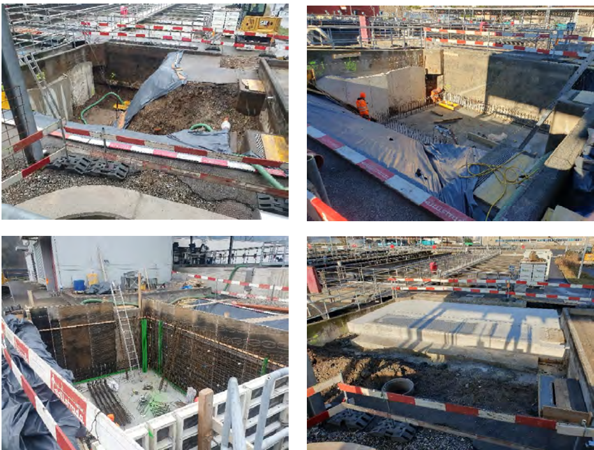
Figura 17 – Nuova camera di estrazione dei fanghi primari.
