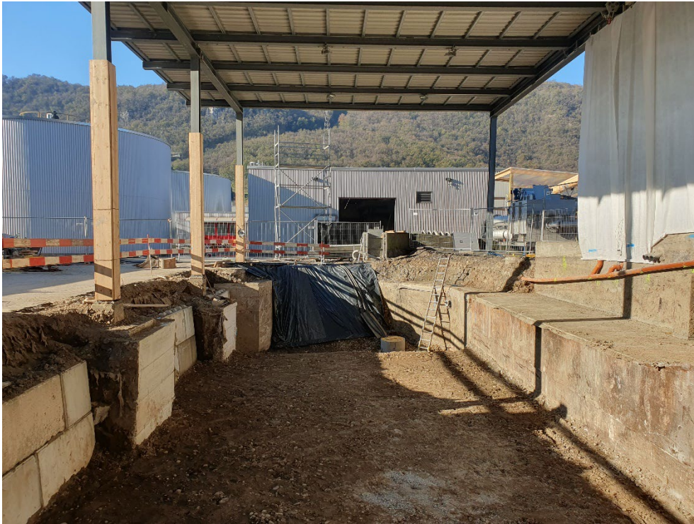
Figura 20 – Pretrattamenti – lavori di scavo e demolizioni.
