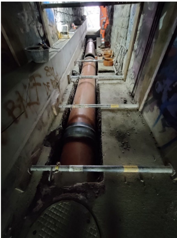
Figura 7 – Intervento S-12B (sottopasso a Capolago).
