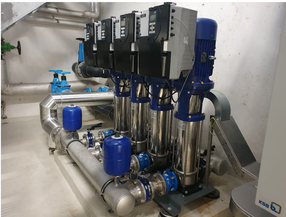
Figura 14 – Nuova stazione di pressurizzazione acqua industriale.
