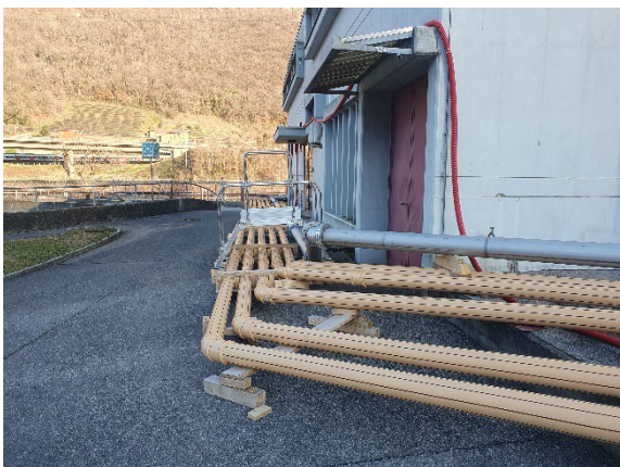
Figura 18 – Pretrattamenti – impianto provvisorio di pompaggio e grigliatura.
