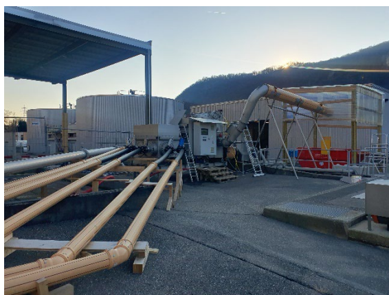
Figura 18 – Pretrattamenti – impianto provvisorio di pompaggio e grigliatura.
