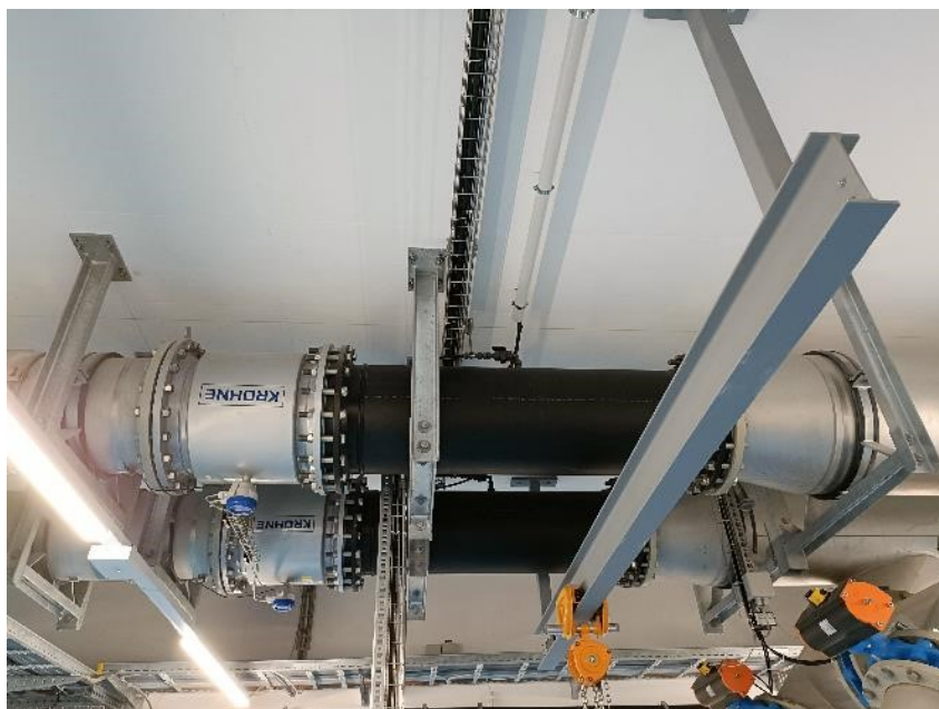
Figura 8: Esempio miscelatore statico in linea
