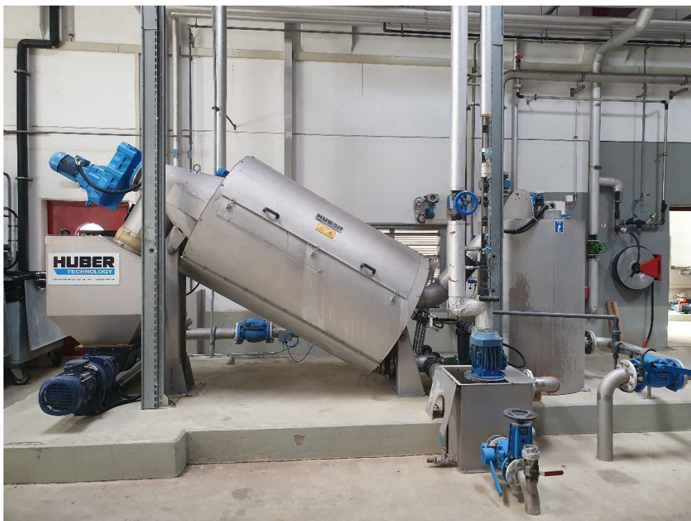
Figura 5 – Preispressitore meccanico (Rotamat).
