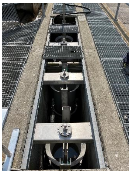
Figura 5: Valvole telescopiche
