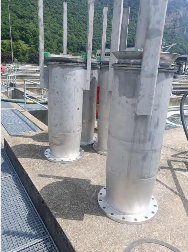
Figura 11 – Valvole telescopiche fango di ricircolo (prima della posa).
