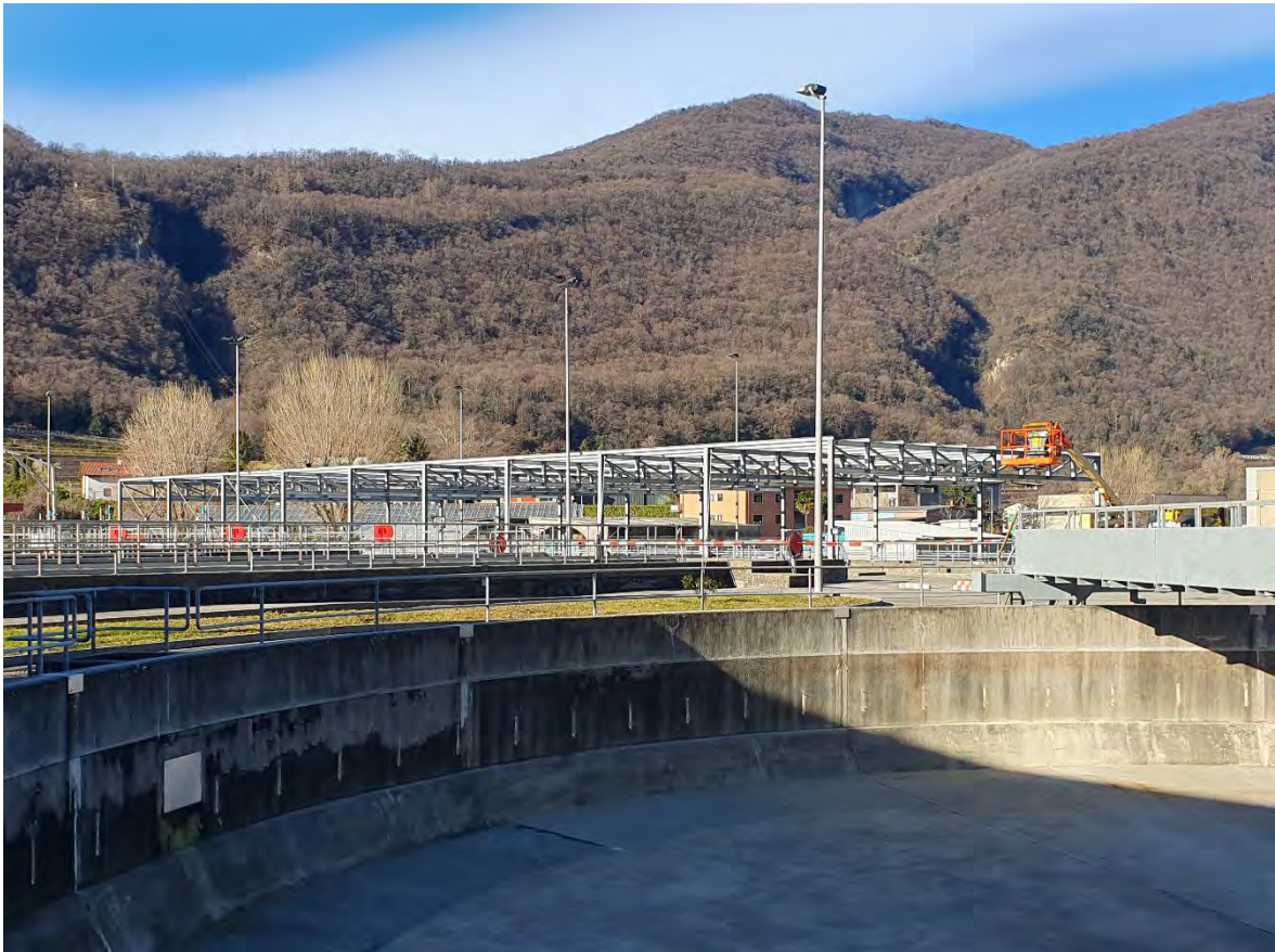
Figura 16 – Struttura portante nuovo impianto fotovoltaico (in costruzione).
