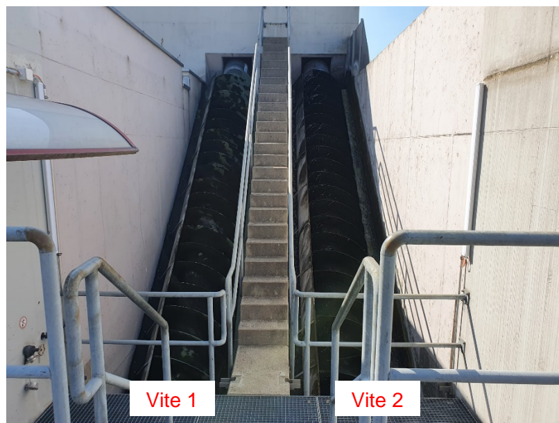
Figura 2 – Viti sollevamento filtrazione.
