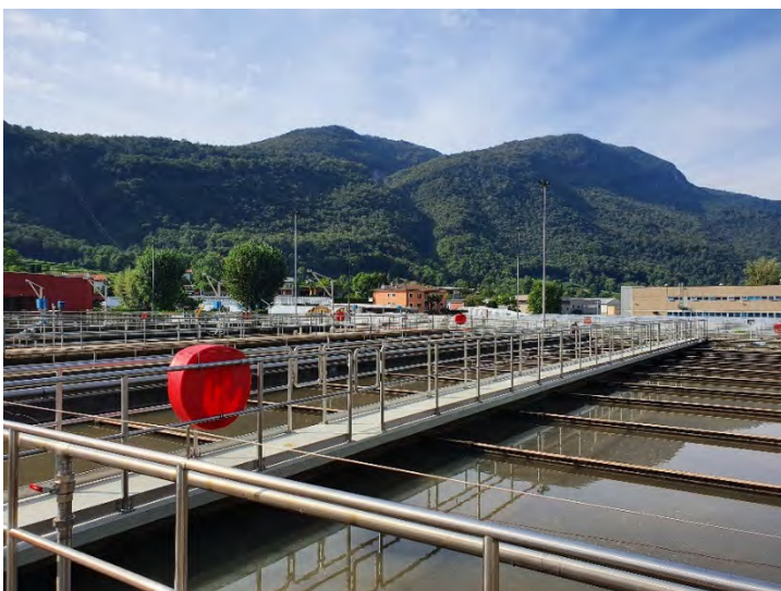
Figura 8 – Nuovi parapetti e risanamento camminamento decantazione primaria.
