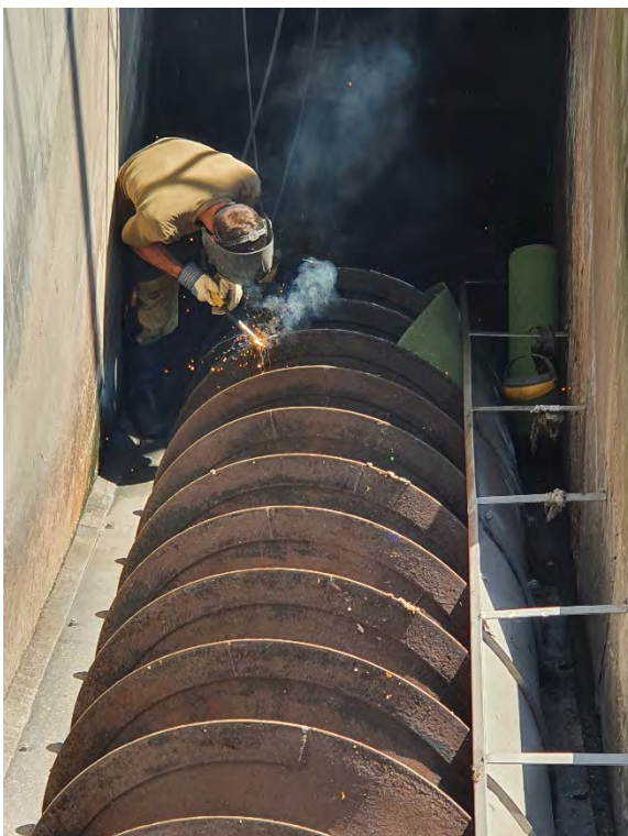
Figura 10 – Riparazione provvisoria vite n°4.
