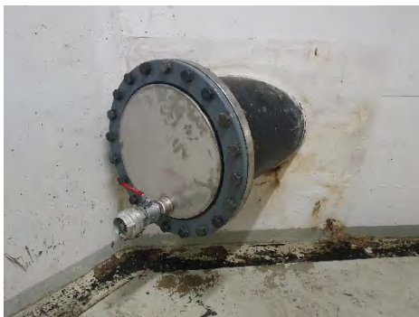
Figura 11 – Dismissione CF4-5: modifiche / smantellamento pompe e tubazioni fanghi.
