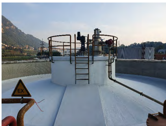
Figura 14 – Risanamento cupole digestori primari – fasi di lavorazione.
