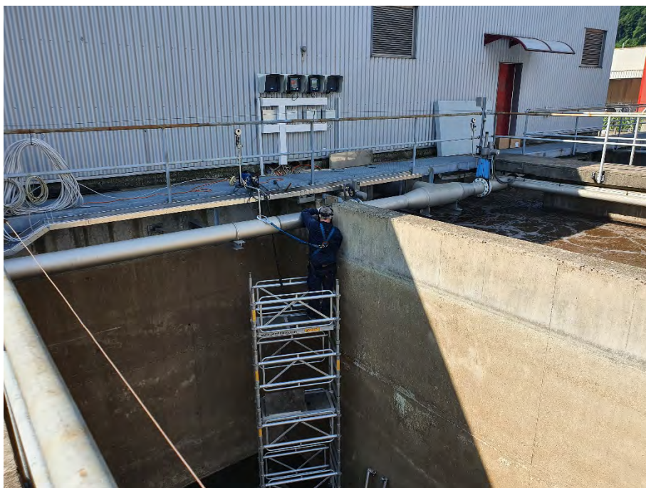
Figura 17 – Modifiche alle tubazioni di distribuzione dell'aria.
