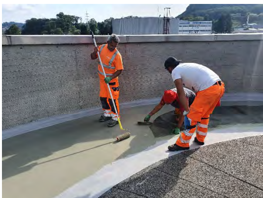
Figura 14 – Risanamento cupole digestori primari – fasi di lavorazione.
