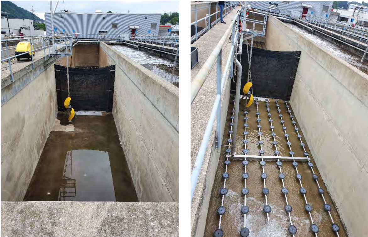
Figura 16 – Formazione zona bivalente linea 1 (prima e dopo i lavori).
