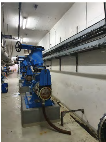
Figura 11 – Dismissione CF4-5: modifiche / smantellamento pompe e tubazioni fanghi.
