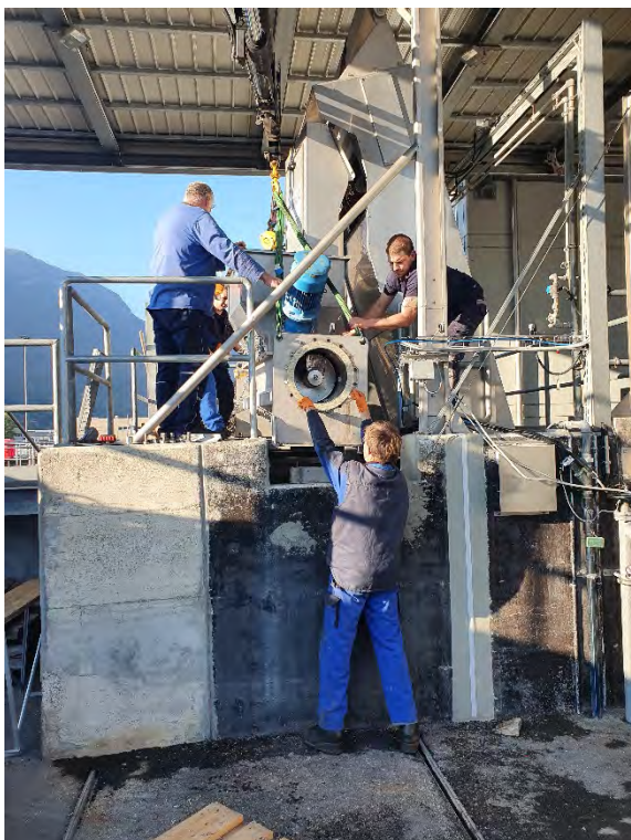
Figura 9 – Manutenzione compattatore griglie fini.
