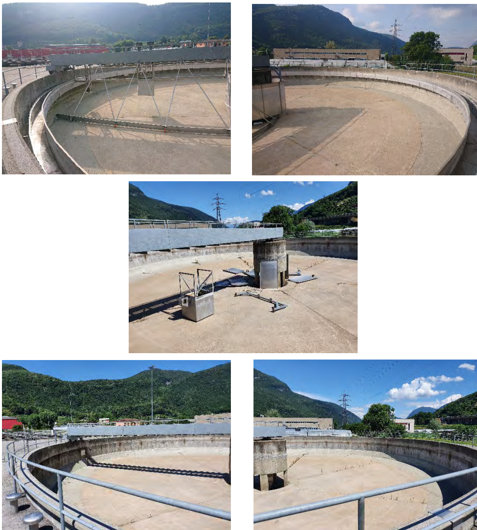
Figura 13 – Dismissione CF4-5: smantellamento componenti metallici CF4.
