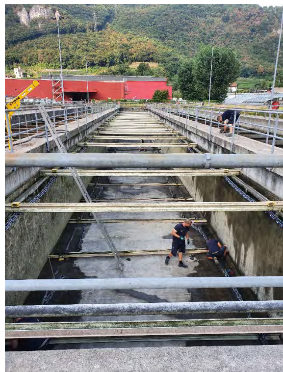
Figura 15 – Sostituzione catene CF2.
