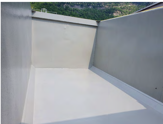
Figura 13 – Risanamento benne fango disidratato.
