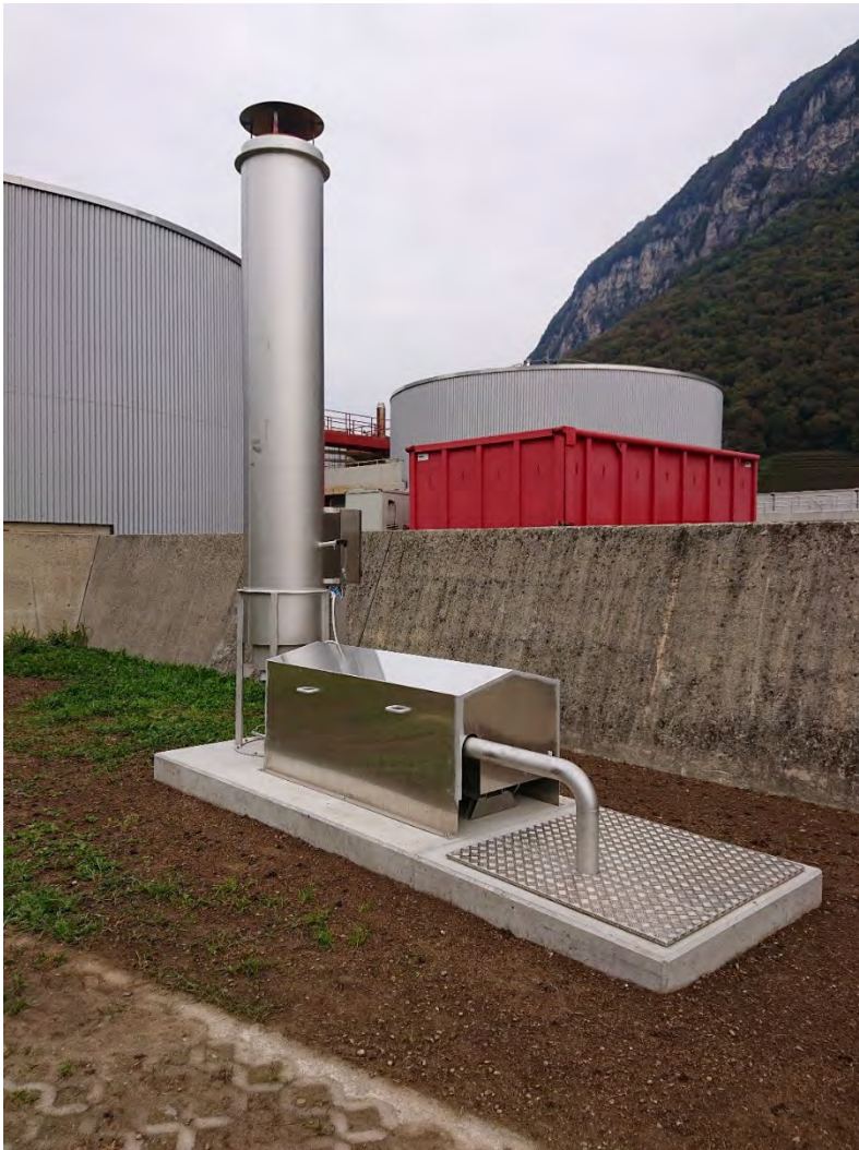
Figura 13 – Nuova torcia d'emergenza.
