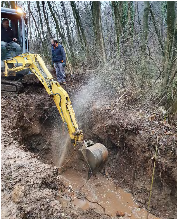
Figura 6 – Rottura puntuale condotta premente ad Arzo.
