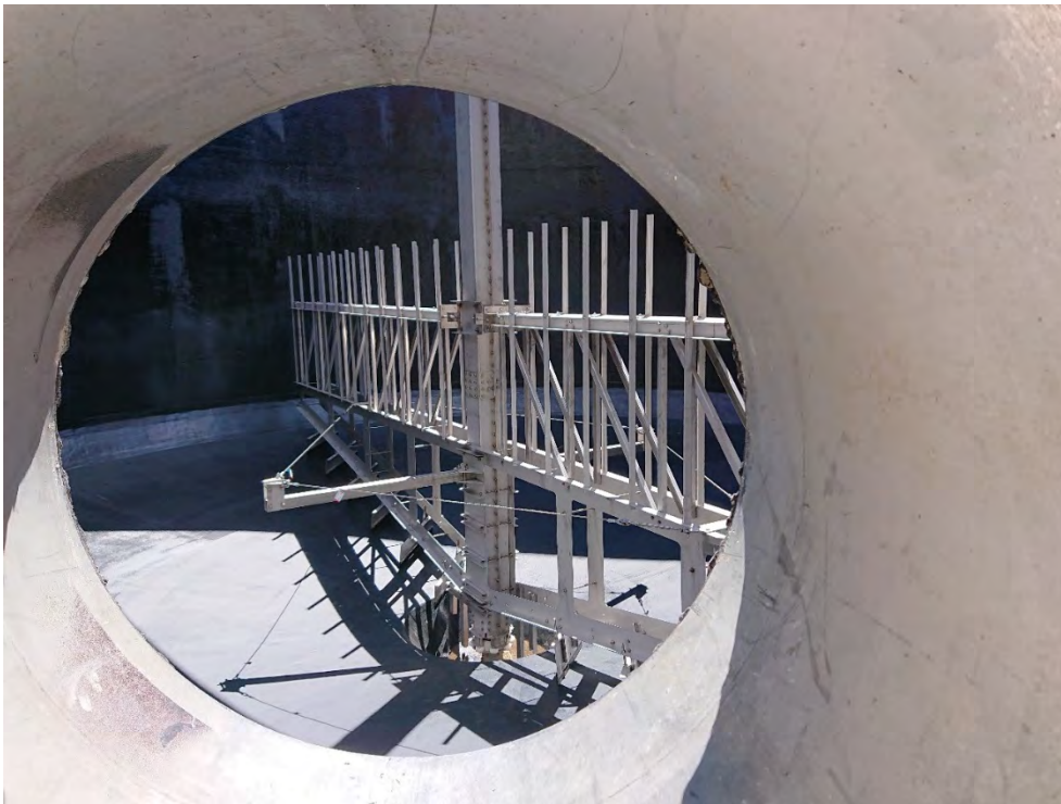
Figura 22 – Nuovo agitatore ispessitore n°1.
