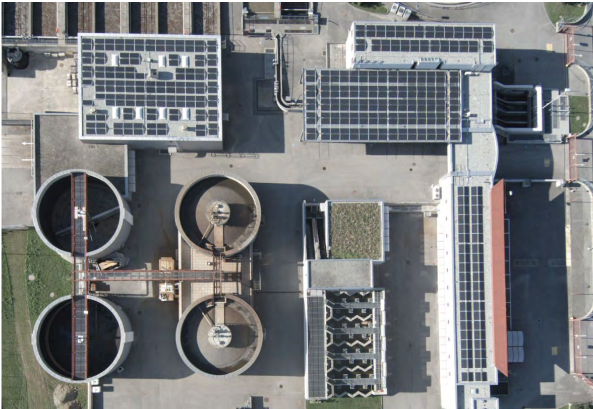
Figura 18 – Visione d’assieme delle coperture con pannelli fotovoltaici.
