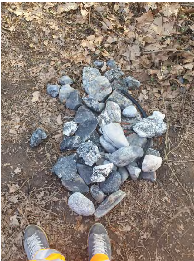
Figura 5 – Materiale ritrovato con la pulizia di un collettore a Genestrerio.
