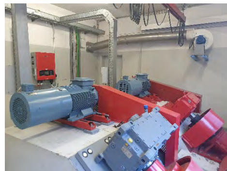
Figura 19 – Locale motori viti prima e dopo sostituzione riduttore n°2 (2019) e motori (2020).
