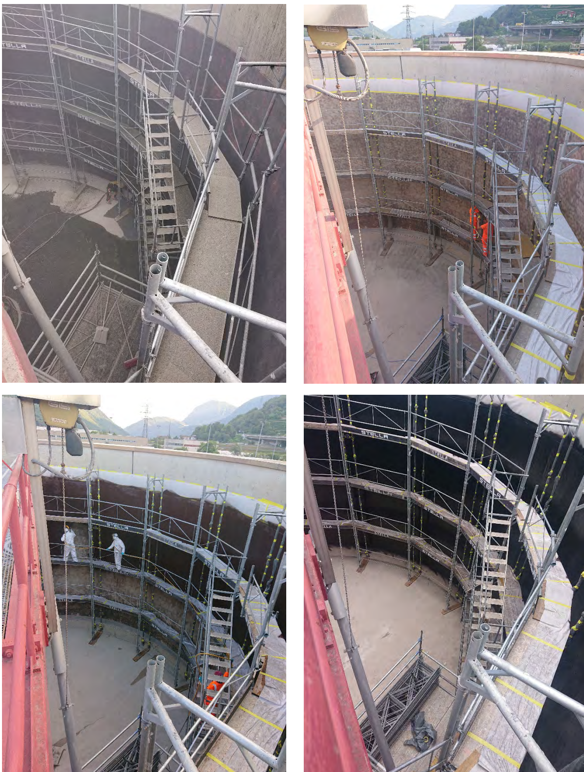
Figura 15 – Fasi di risanamento delle pareti dell'ispessitore n°2.
