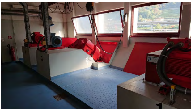
Figura 19 – Locale motori viti prima e dopo sostituzione riduttore n°2 (2019) e motori (2020).
