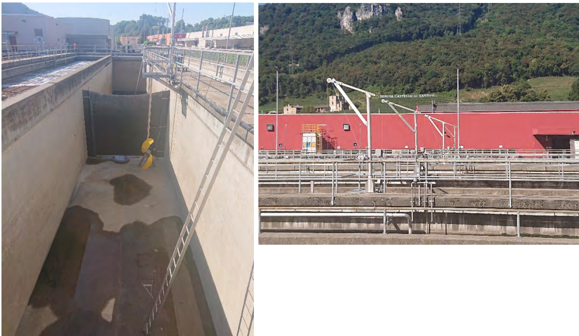
Figura 21 – Nuovo agitatore biologia n°4 e nuovi pali di sollevamento agitatori.
