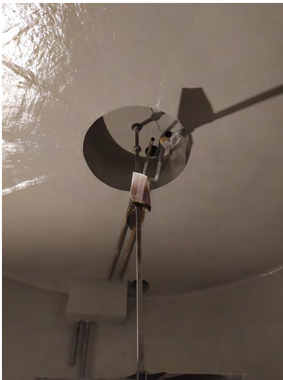
Figura 14 – Interno digestore 2 risanato.
