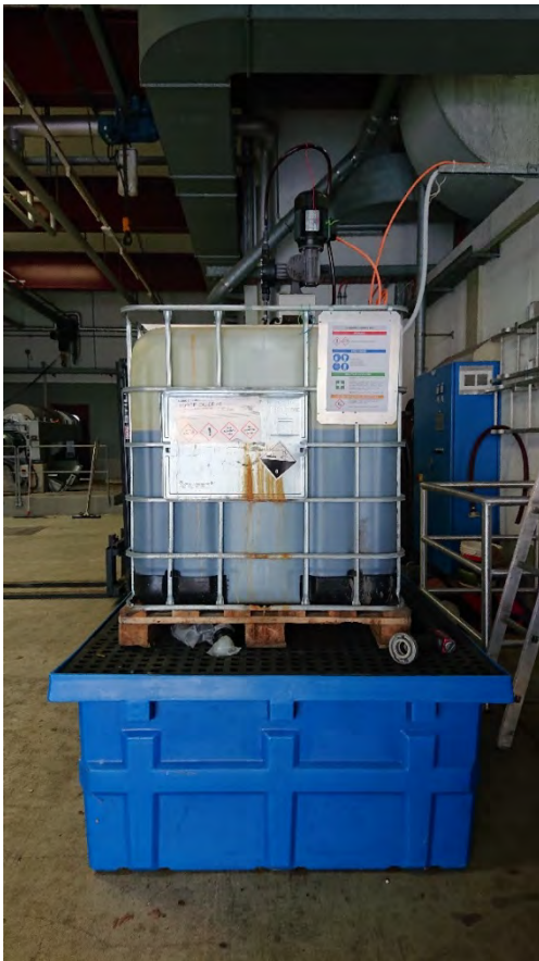
Figura 15 - Nuova stazione di dosaggio cloruro ferrico.
