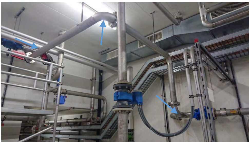
Figura 17 - Collegamento fanghi primari - ispessitore dinamico.
