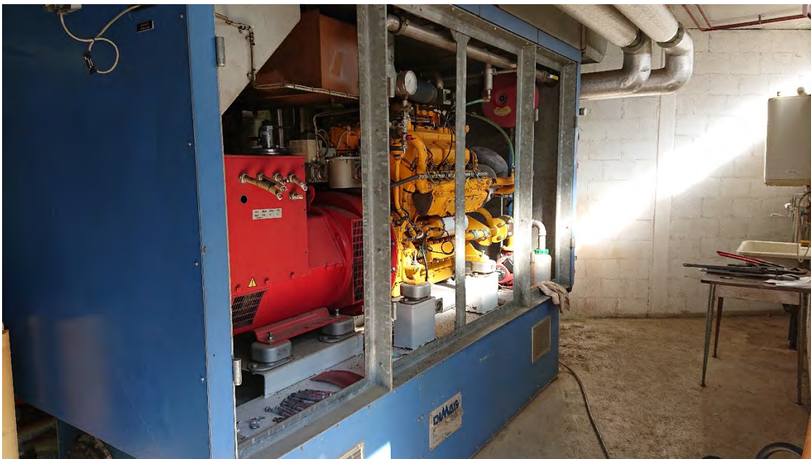
Figura 24 - Cogeneratore CDAM in fase di smantellamento.
