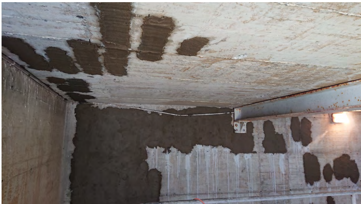
Figura 8 - Bacino Chiesa (Melano) - calcestruzzo risanato.
