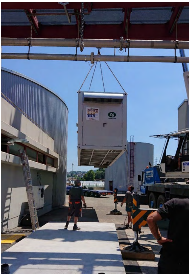
Figura 27 - Posa container nuovo cogeneratore AIM.
