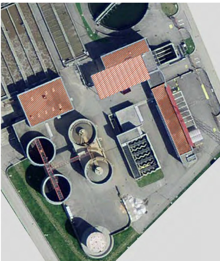
Figura 29 - Tetti dove è prevista la posa di impianti fotovoltaici.
