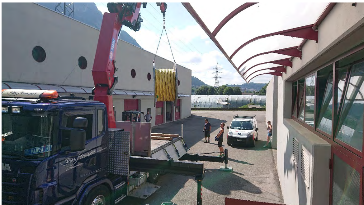
Figura 25 - Nuovo cavo cogeneratore-reti di distribuzione.
