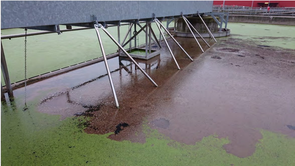
Figura 21 - Sollevamento fanghi nel sedimentatore n°4.
