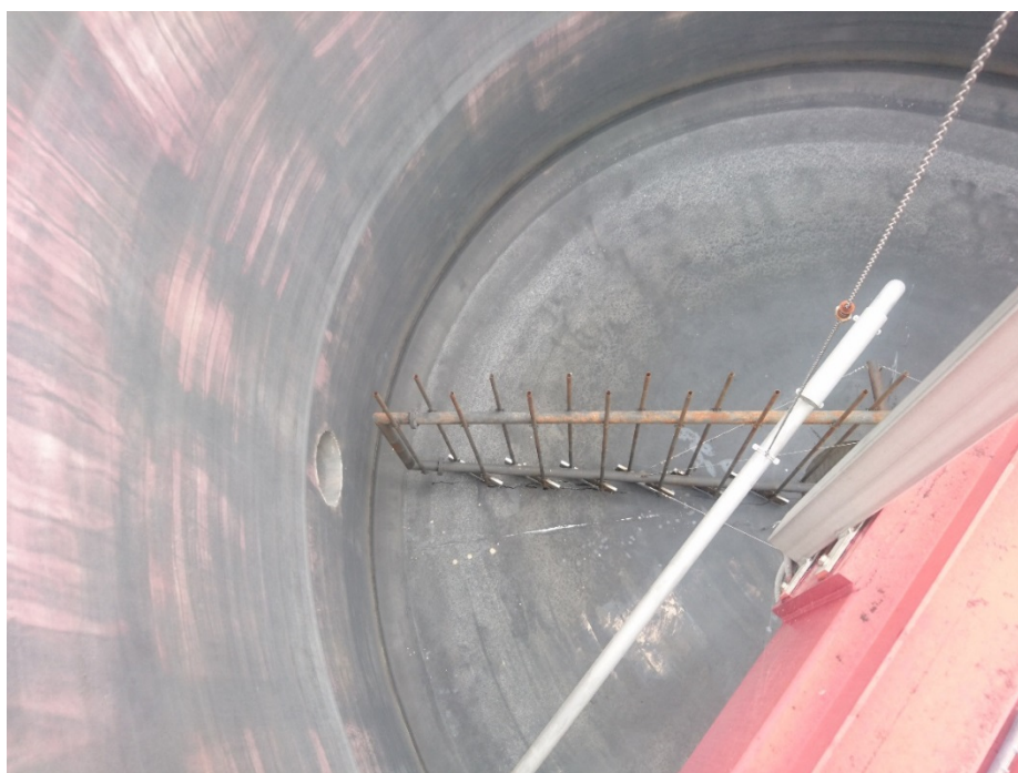
Figura 6 – Digestore secondario – braccio mobile.
