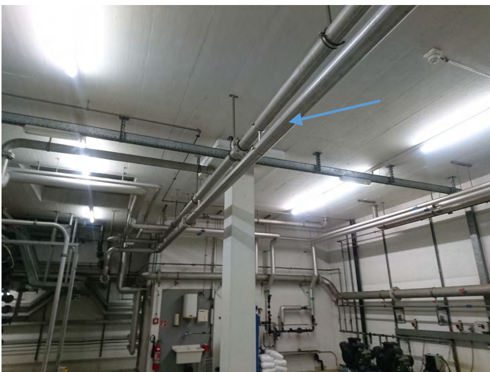
Figura 42 – Nuova tubazione scarico acqua ispessitore fango di supero.
