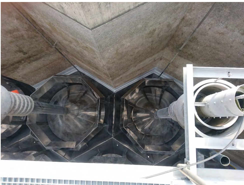
Figura 41 – Filtro a sabbia n°3: deposito temporaneo sabbia e nuovo giunto.
