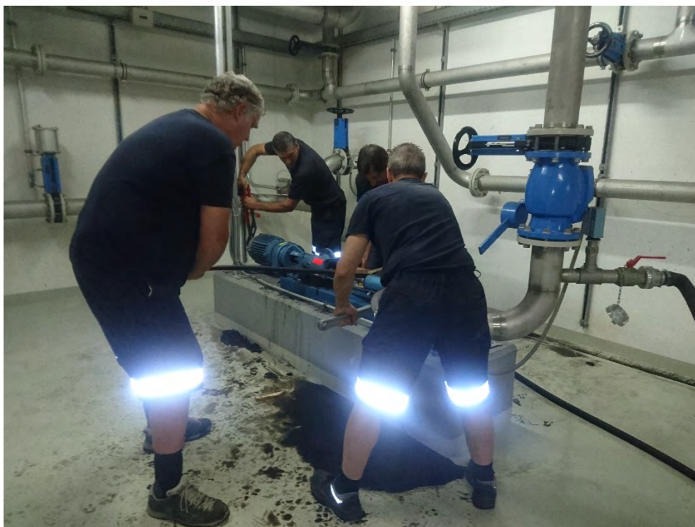
Figura 36 – Disotturazione pompa fanghi digeriti.
