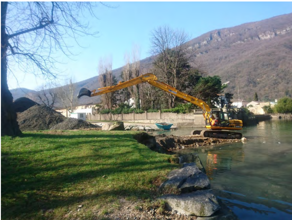
Figura 5 – Dragaggio della Foce del Fiume Laveggio (marzo 2017).
