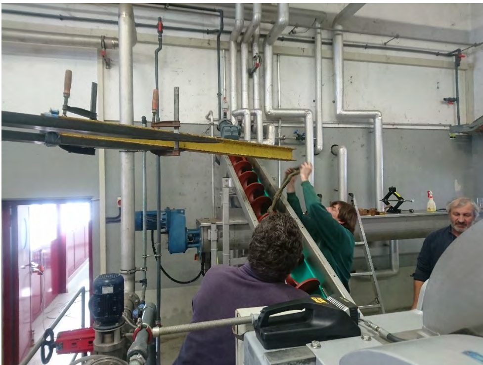
Figura 39 – Sostituzione coclea centrifuga.
