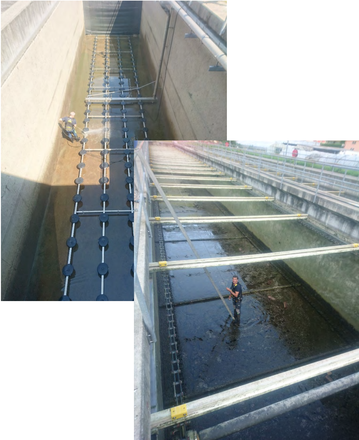
Figura 35 - Pulizia piattelli vasca di biologia 4 e sedimentatore 2.
