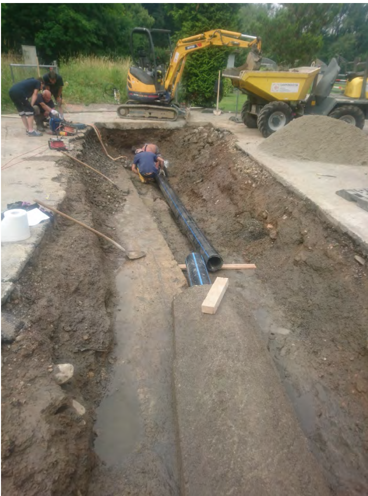
Figura 6 – Riparazione condotta premente ad Arzo.
