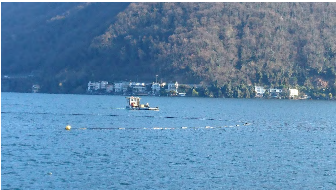
Figura 12 - Assemblaggio della condotta sublacuale nei pressi del ponte-diga.
