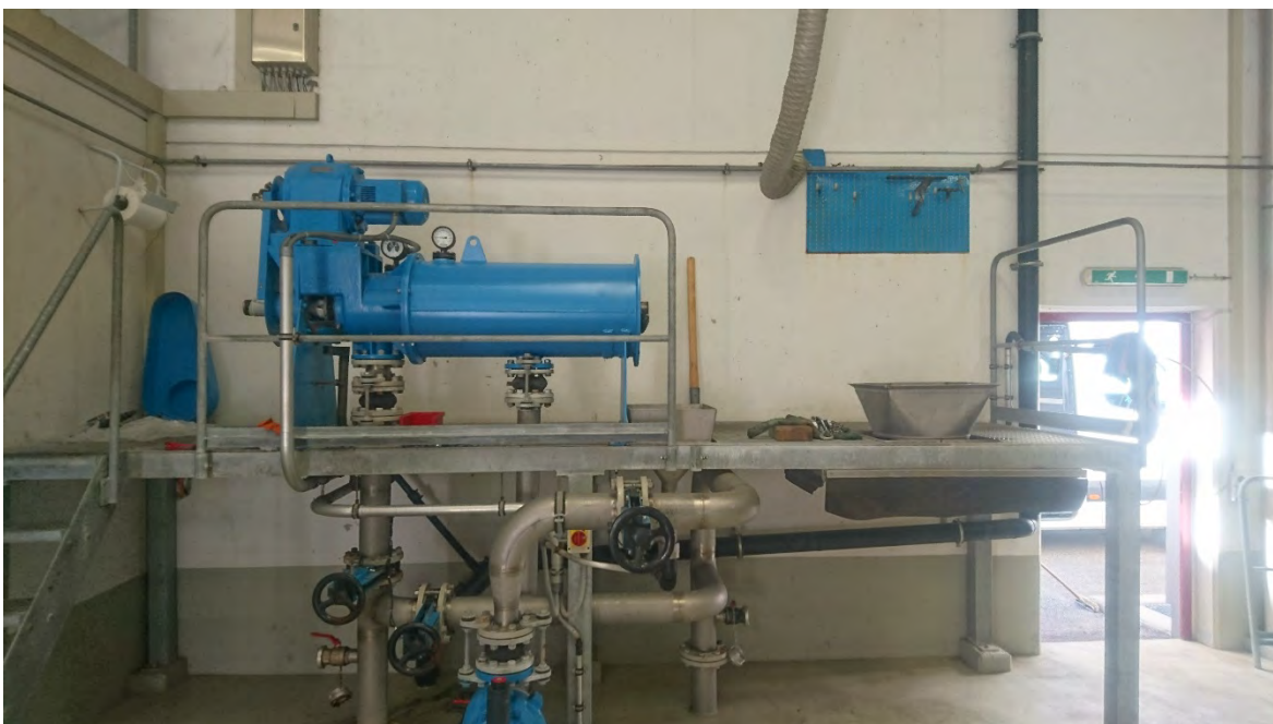
Figura 50 - Sostituzione in corso della carcassa della Strainpress.
