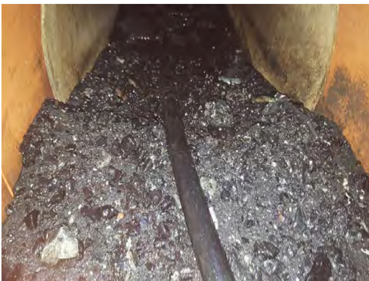
Figura 8 - Esempi di materiale riscontrato nei collettori.
