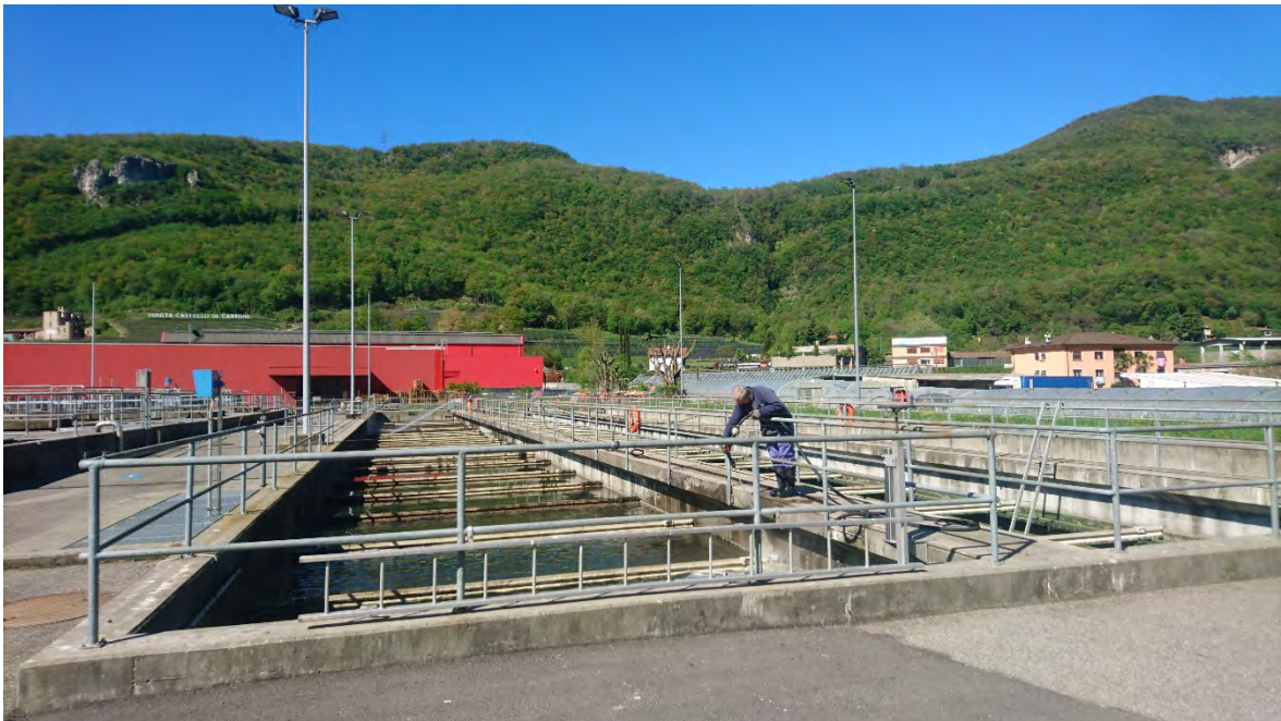
Figura 46 - Pulizia pattini sedimentatori longitudinali.
