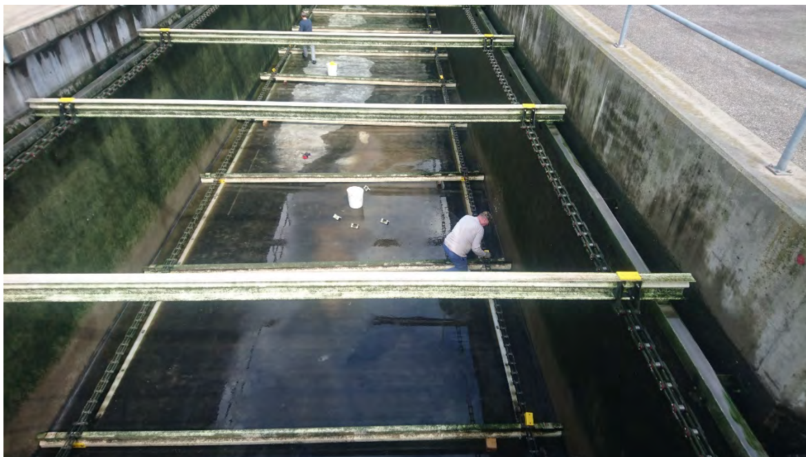
Figura 48 - Sostituzione dei pattini dei sedimentatori da parte del personale CDAM.
