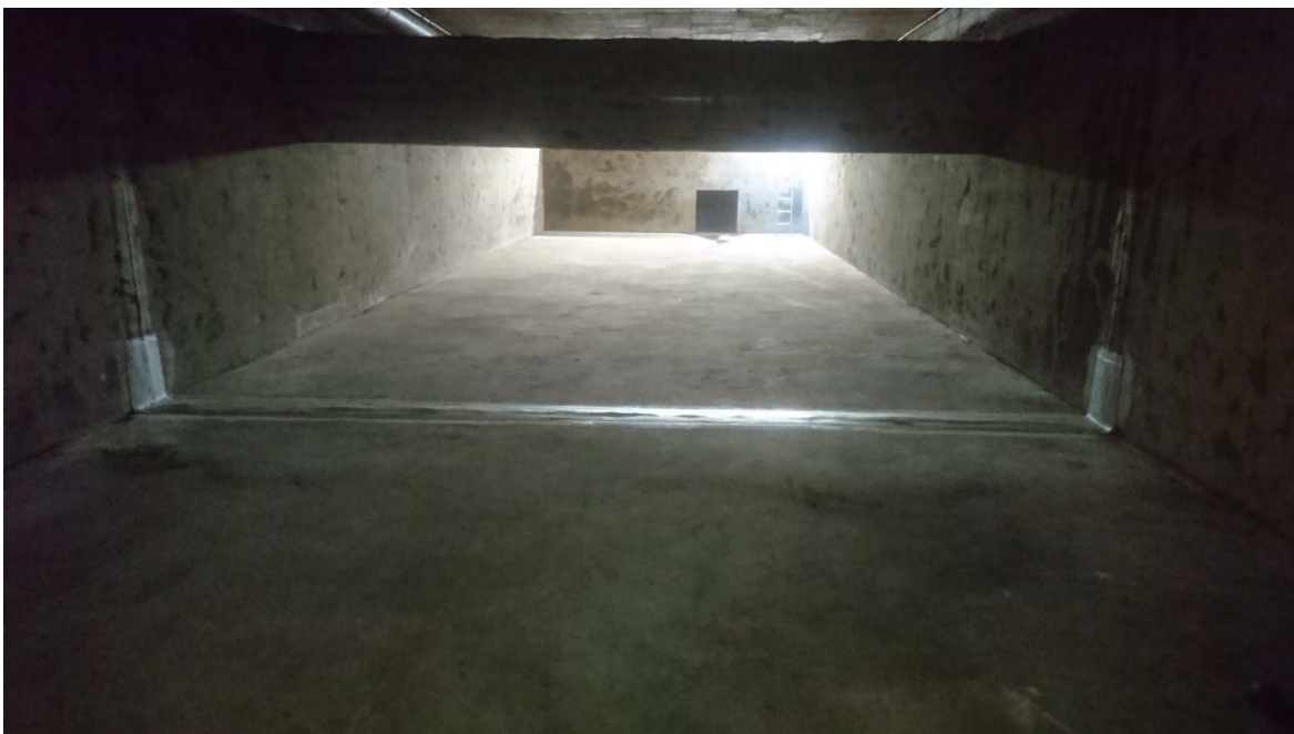
Figura 52 - Riparazione giunti bacino acque piovane.
