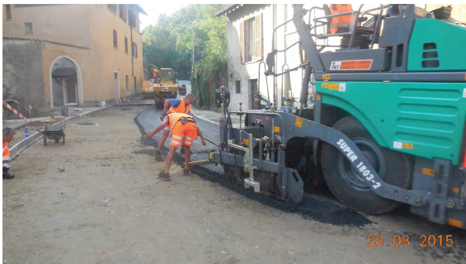
Figura 5 - Cantiere Largo Soldini: parte a monte (via Pozzi Artisti).
