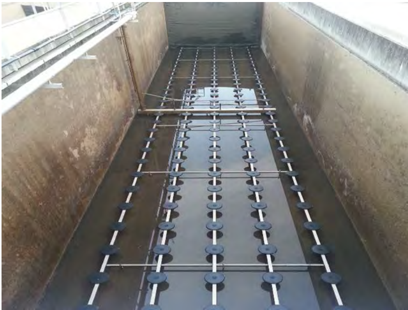
Figura 37 - Svuotamento e pulizia biologia 4 e decalcificazione piattelli.
