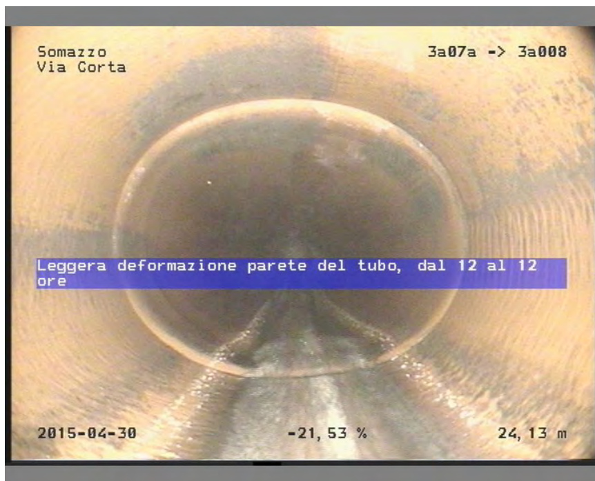
Figura 2 - Esempio di ispezione con telecamera dei collettori.
