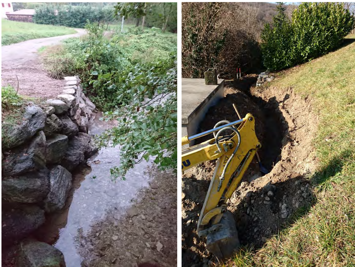
Figura 3 - Interventi alla stazione di pompaggio di Meride.
