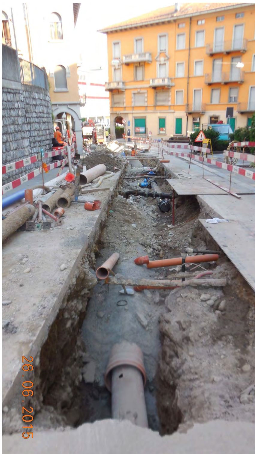
Figura 6 - Cantiere Largo Soldini: parte a valle.
