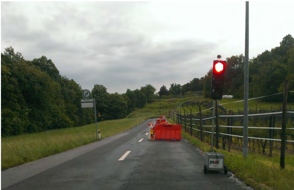
Figura 4 - Sostituzione di chiusini a Tremona.
