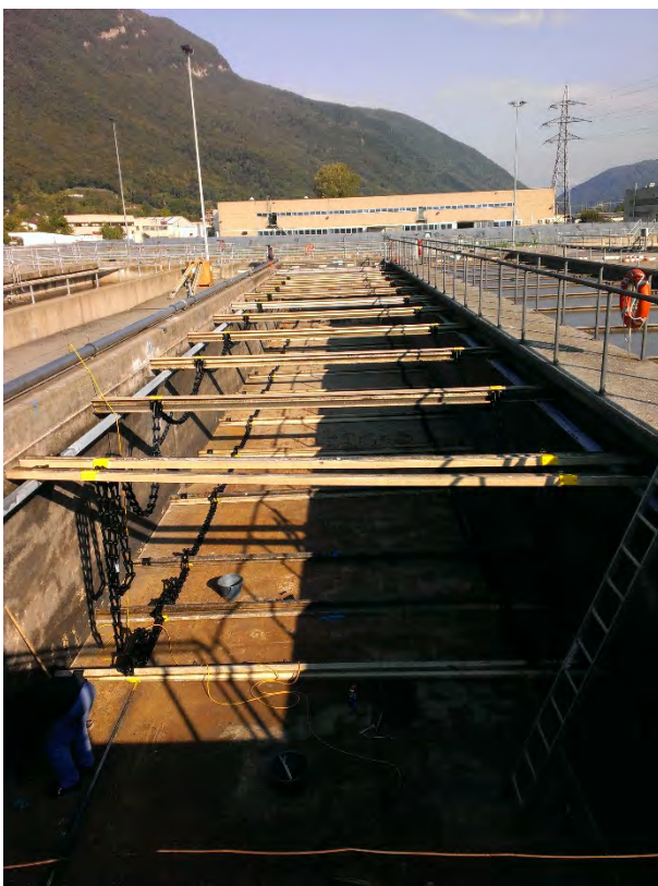
Figura 39 - Montaggio delle nuove catene del carroponete della decantazione primaria.
